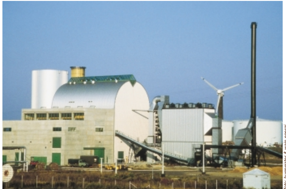
Das Heizkraftwerk Masnedø wurde 1996 in Betrieb genommen und verbraucht jährlich ca. 40.000 Tonnen Stroh und ca. 8.000 Tonnen Holzhackschnitzel.
