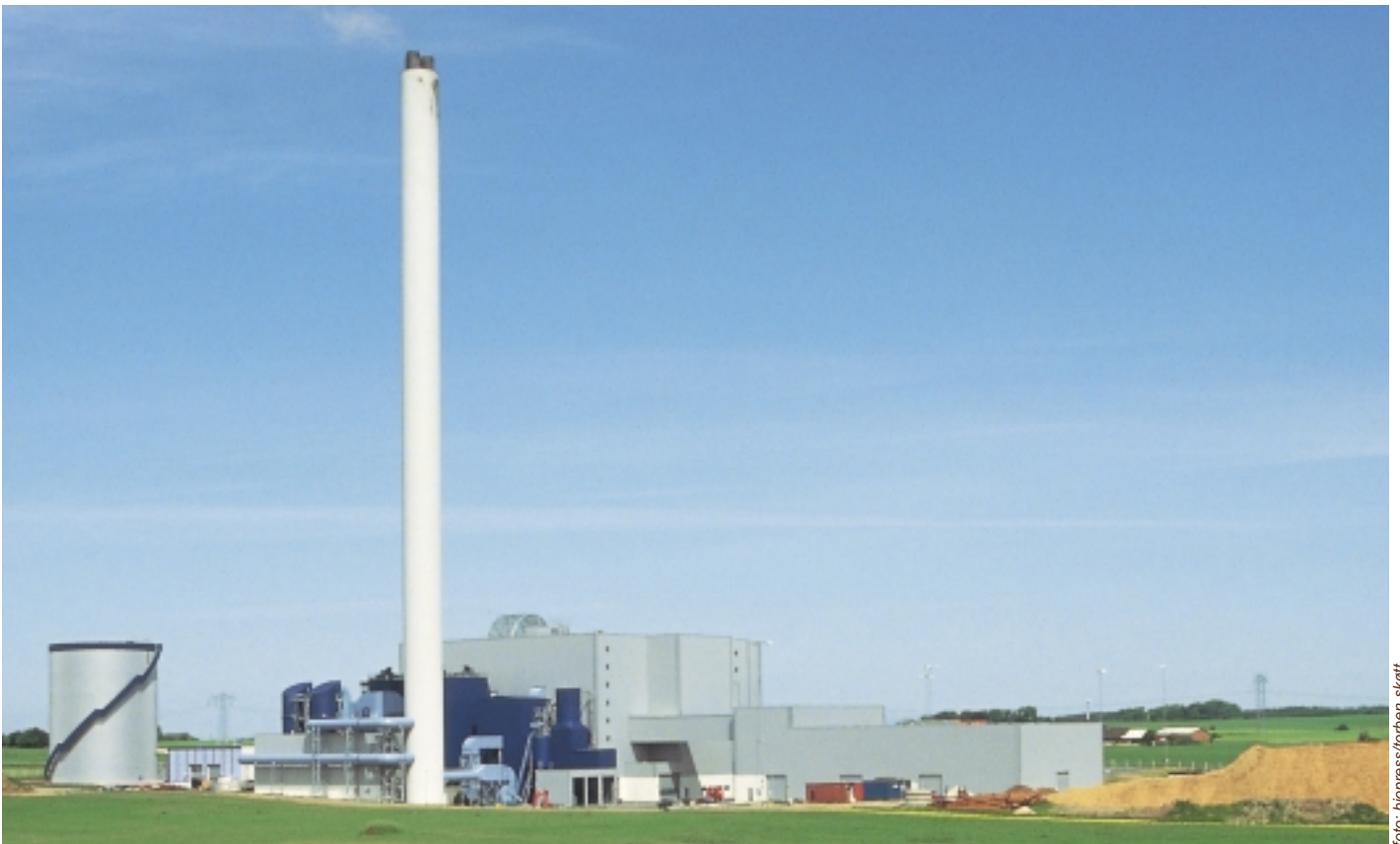
Das Måbjerg-Werk. Links der 5000 m 3 -Speicher. Das Strohlager ist in dem niedrigen Gebäude rechts untergebracht. Ganz rechts das nicht überdachte Hackschnitzel-Lager.
