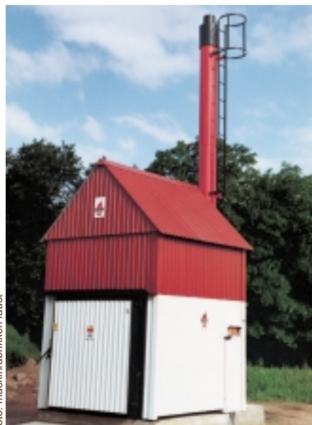
foto: maskinfabrikken faust
