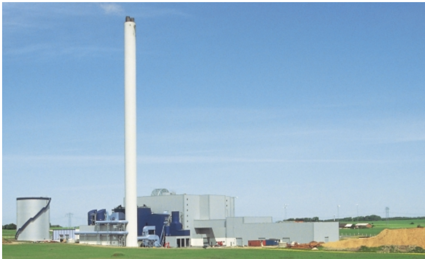
Måbjergværket. Til venstre ses akkumuleringsstanken på 5.000 m 3 . Halmageret er den lave bygning til højre. Yderst til højre ses det udendørs flislager.
