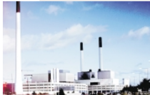
I/S Amagerforbrænding Cogeneration based on MSW
